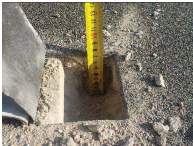
foto /1/ Pohled na provedenou sondu do stávající skladby střechy
